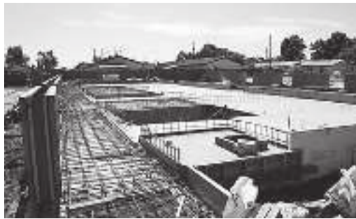
進む錦町団地公営住宅建築工事
