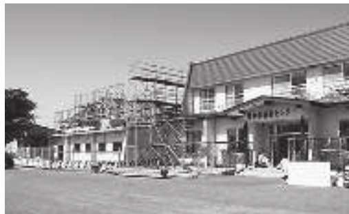
青少年研修センター体育館耐震改修工事
