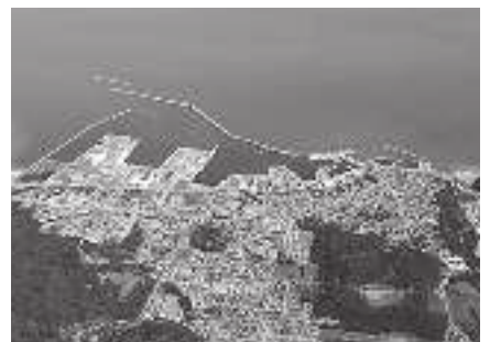
上空からの十勝港（帯広開発建設部提供）
