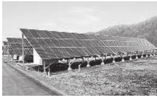
茂寄地区のソーラー発電施設建設現場
