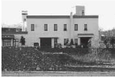
下水道処理場
