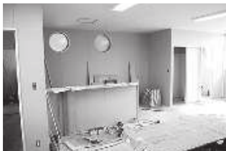
改修が進む支援センター
