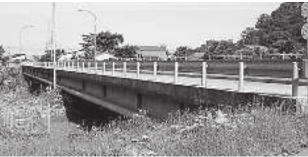
町管理の音調津大橋（昭和50年建設）
