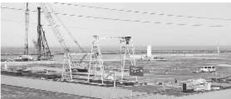
飼料コンビナート建設工事(十勝港第4ふ頭)
