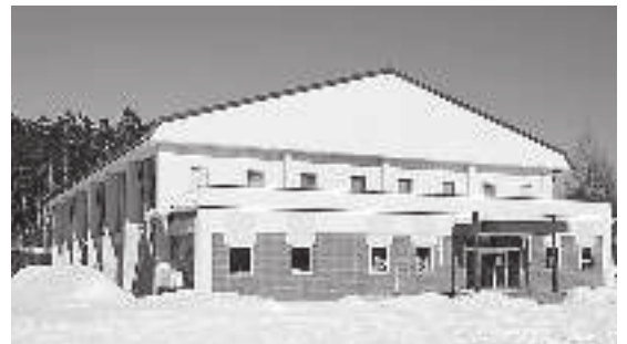
耐震補強工事が完了した第二小体育館
