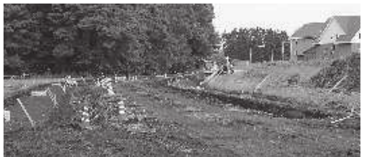
計画的に整備が進む町道（墓園前道路）
