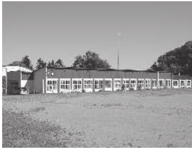
地域住民のためにどう利用すべきか（音調津小学校校舎）
