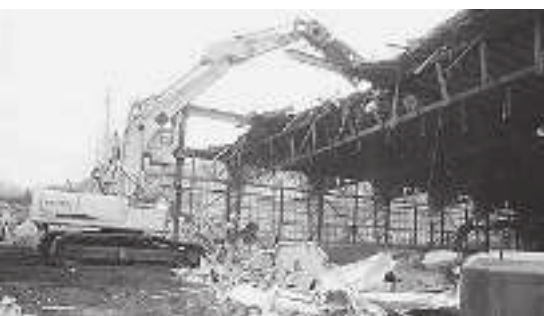
取り壊された柔剣道場
