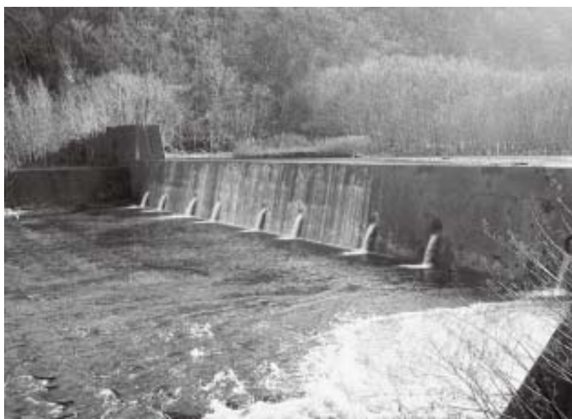
西広尾川砂防ダム
