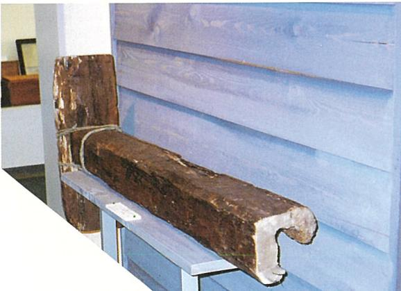
広尾町上水道敷設の嚆矢を物語る木管が昭和四十二年（一九六七）の第三次上水道拡張工事の道路拡幅工事で発見された。木管の一部と継手の一部で、材質は桂の木、凹字型に削ったものを重ね合わせたもので、重ね目に犬釘を用いている。材の表面は鋸で切ったものでなく「チヨウナ（手斧・鋸）」のようなもので面を削っている。計測したところによると、長さ一四一センチ幅一五センチ厚さ六センチ継手部は横が六八センチ幅が二五センチで厚さが九センチとなつていて、木管の年代測定は行っていないが記録から次のようなことがうかがえる。
