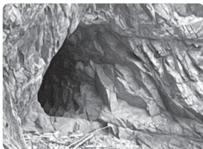
田中五郎右衛門により開削された、鑿と発破の跡も生々しい隧道。高さ2.9m、幅は2.6mあり乗馬した人も通れる高さ。昭和9年の黄金道路完成まで山道と併用された(※2)
